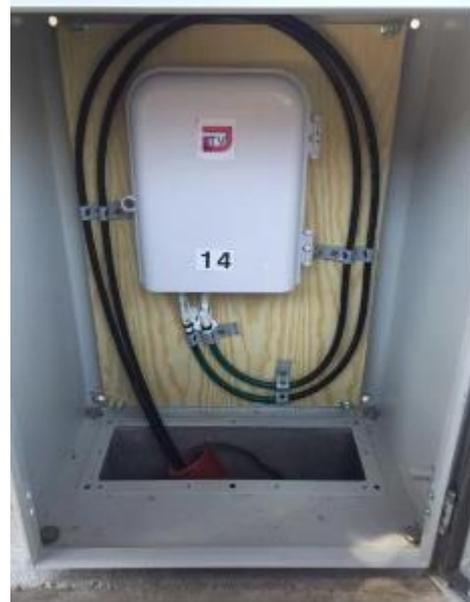
En las instalaciones en exterior en poste o pedestal, se utilizan los mismos elementos que en instalaciones en exterior en fachada: Caja terminal óptica (CTO) exterior y Cables de acometida.
